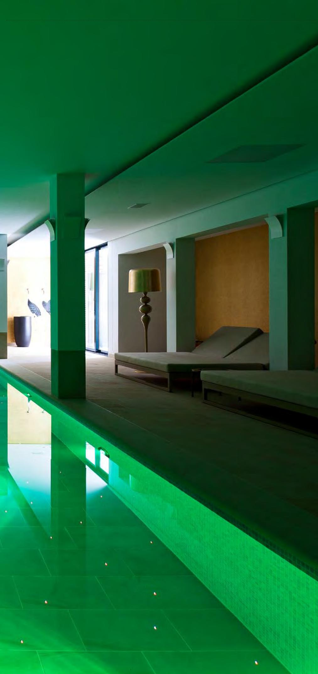
Die Projektoren konnten direkt am Becken positioniert werden. Die Lichtpunkte sind jetzt wie die LED-RGB-Beckenscheinwerfer und die ebenso aufwendige Raumbeleuchtung auch auf die Steuerung Ospa-Blue-Control aufgeschaltet. Selbst die zweidüsige Gegenstromanlage verfügt über eine LED-Beleuchtung.
