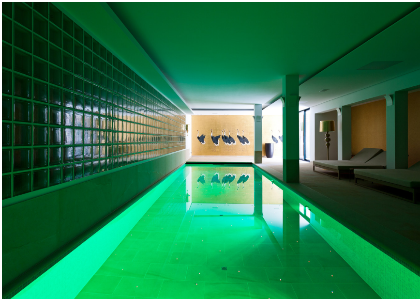
140 Lichtpunkte wurden in den Beckenboden eingebracht. Zusammen mit den normalen Unterwasserscheinwerfern entfalten sich attraktive Farbenspiele im Wasser. Rechts: Die Technik ist hinter eine Wand verborgen.
